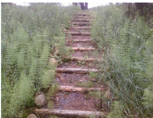
Рисунок 20 – Устройство насыпной лестницы
