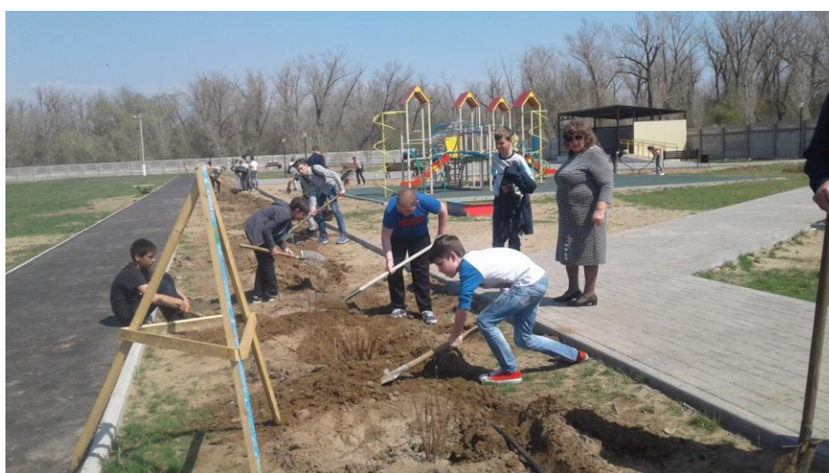
Рис. 39. Укладка труб капельного полива
