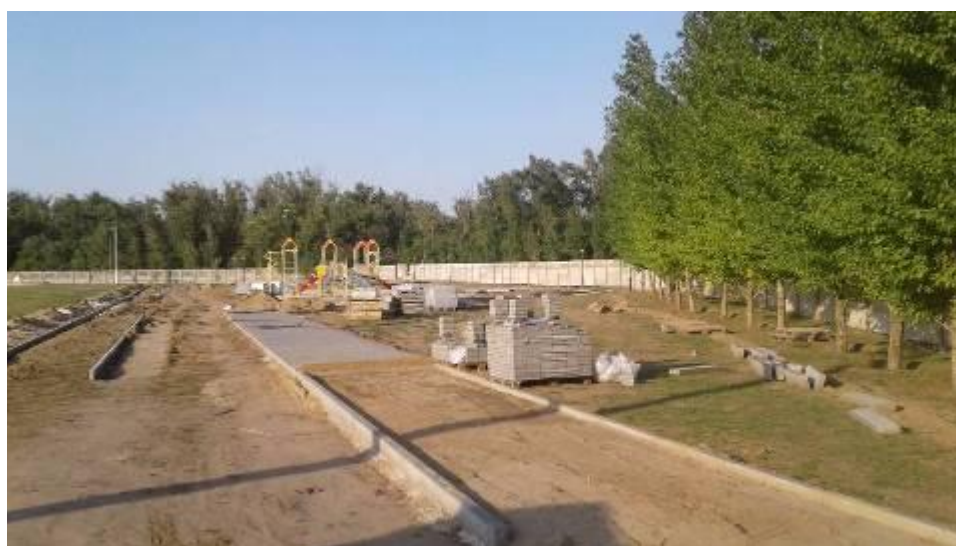
Рис. 2. Работа по благоустройству
