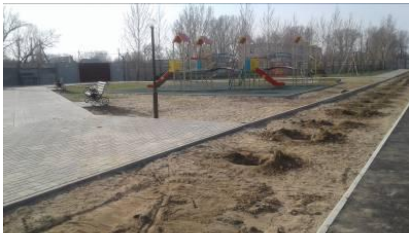
Рис. 3. Территория стадиона п. Куйбышев после реконструкции
